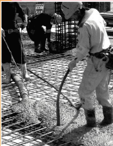
コンクリート打設、締固め
